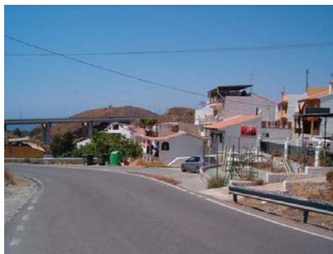
Carretera actual. Viaducto ronda circunvalación.
