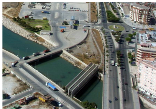
Puente actual del ferrocarril sobre el río
