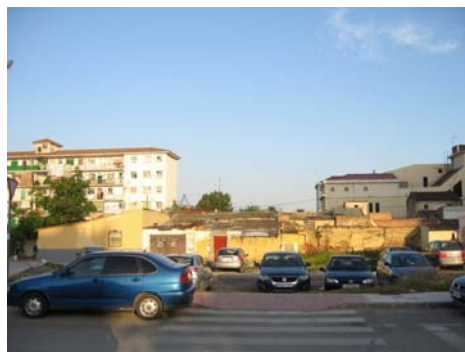
Fachada actual a C/ Pacífico
