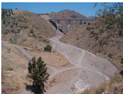
Arroyo Gálica y viaducto autovía
